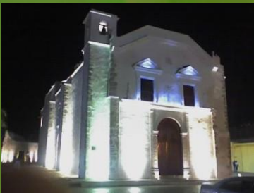
REHABILITACION DE LA IGLESIA DE SAN JUAN DE DIOS
